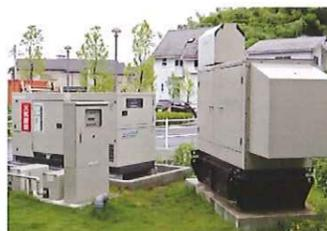
分院では震災対策のため昨年9月オープン時に設置した非常用発電機(写真右)と併せて7月下旬にもう1台非常用発電機(写真左)を設置いたしました。「人工呼吸器」「透析機器」「厨房IH機器」等、電力を必要とする器機が地域一帯停電になっても安定的に稼働するよう対応しています。
